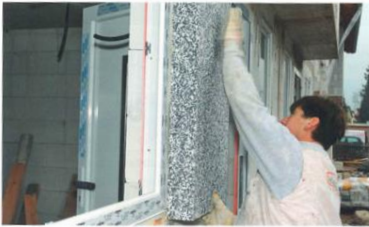
1 Eine Hauswand wird gedämmt.
